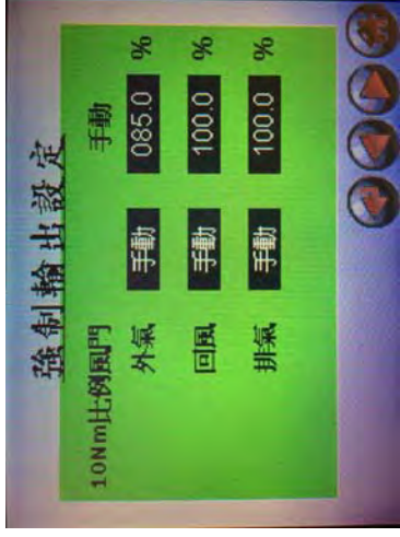
該頁次設定外氣、回風、排氣各 10Nm 比例風門的手/自動選擇及手動輸出值。
